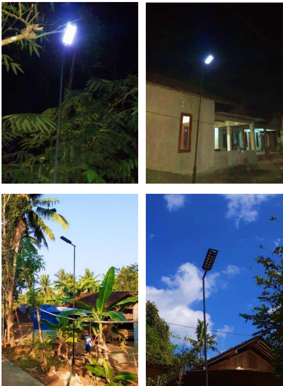
Gambar 9. Sampel Kondisi Lokasi Pemasangan PJUTS (Sumber foto adalah hasil inspeksi lapangan oleh penulis)
