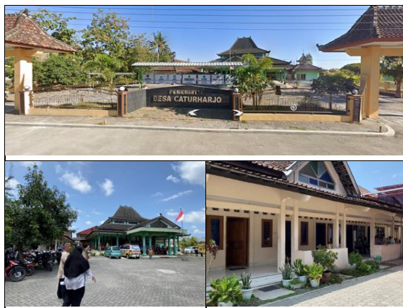
Gambar 9 Kondisi eksisting proyek. (Sumber: koleksi pribadi, 2021)
